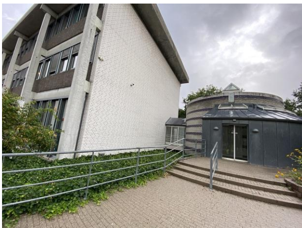
#9 Sydlige tilbygning set fra sydøst.
